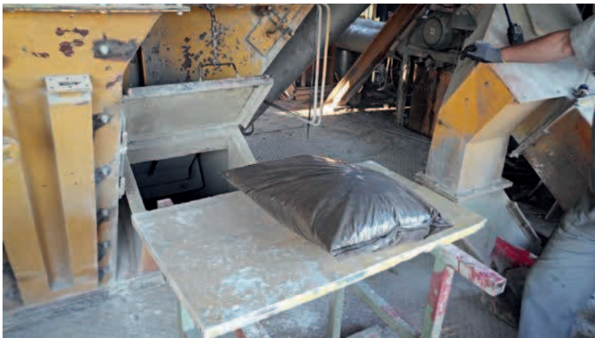
Beigabe von Gilsonite-Kleinverpackung in den Asphaltmischer
